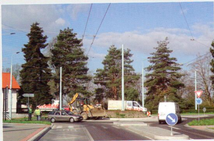
Obrázek 3: Oprava klasického betonového prstence na křižovatce Kyjevská x Průmyslová
