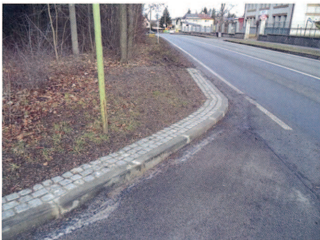
Obr. 3 Masivní boční opěra krytá žulovou kostkou
