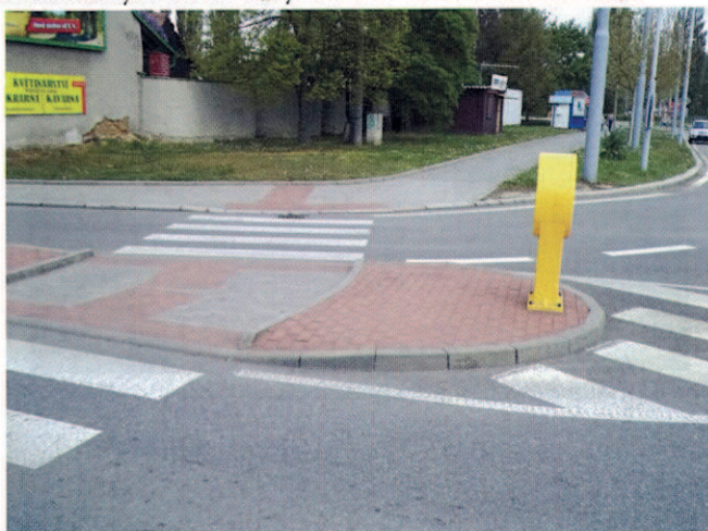
Obr. 8 Klínové snižování obruby, chodníková oboustranně nad úroveň dlažby
