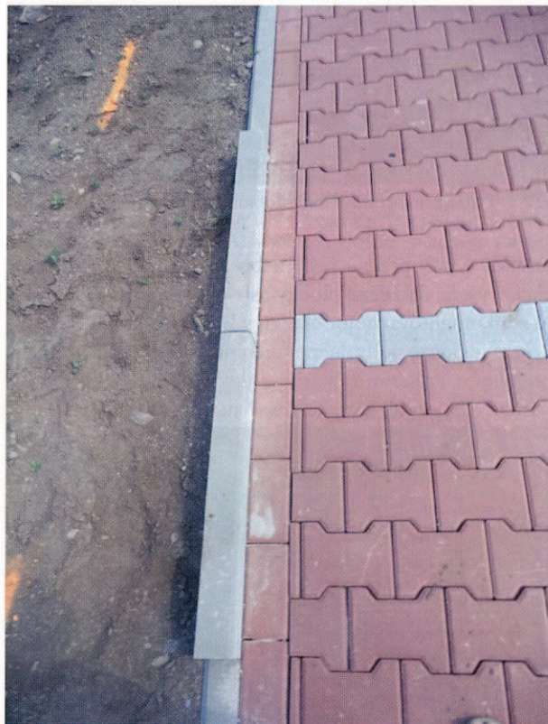
Obr. 6 Dlažba chybně v pískovém loži, zbytečný dořez
