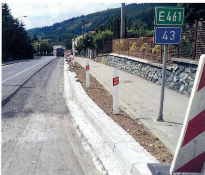
Obr. 4 Masivní boční opěra (foto ze stavby)
