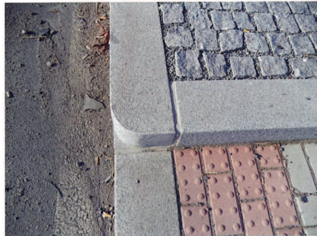
Obr. 9 Hlavové ukončení obruby
