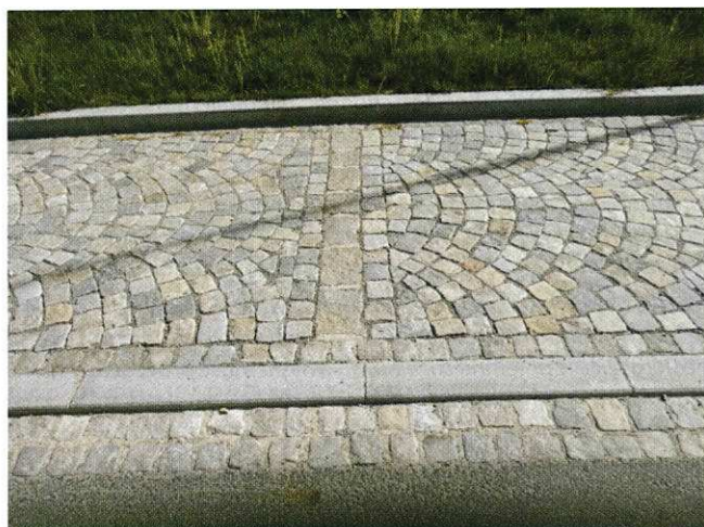
Obr. 15 Detail poctivé pokládky dlažby. Dělicí a opěrné prvky jsou lemovány řádkou kostek do betonu
