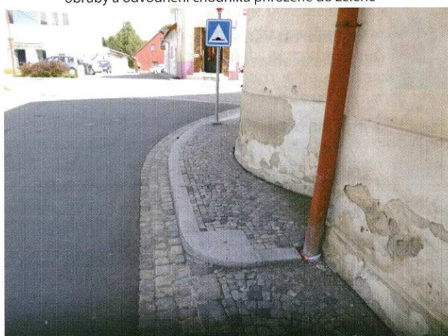
Obr. 14 Detail nárožní obruby u „odrazného“ proužku
