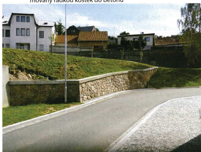
Obr. 16 Kamenná zárubní zeď
