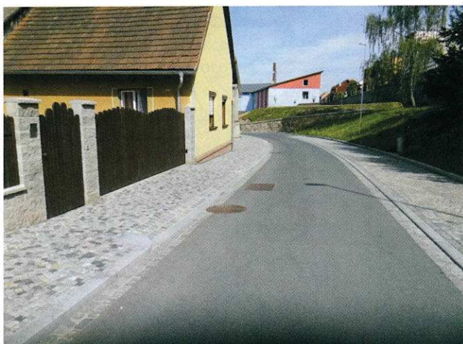
Obr. 8 Modernizovaný uliční prostor – chodník, jízdní pruh, parkovací pruh
