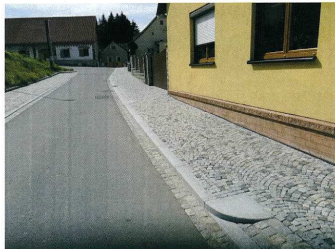
Obr. 11 Detail snížení obruby u samostatného sjezdu
