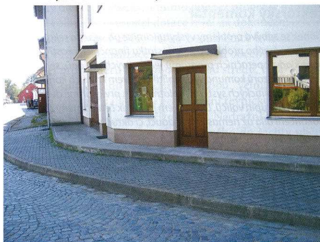
Obr. 3 Špatné výškové řešení, dvojí obruba různého provedení, nesourodá dlažba
