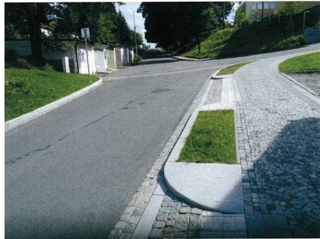
Obr. 12 Detail nárožního kamene a vjezdů, užívaných zemědělskou technikou
