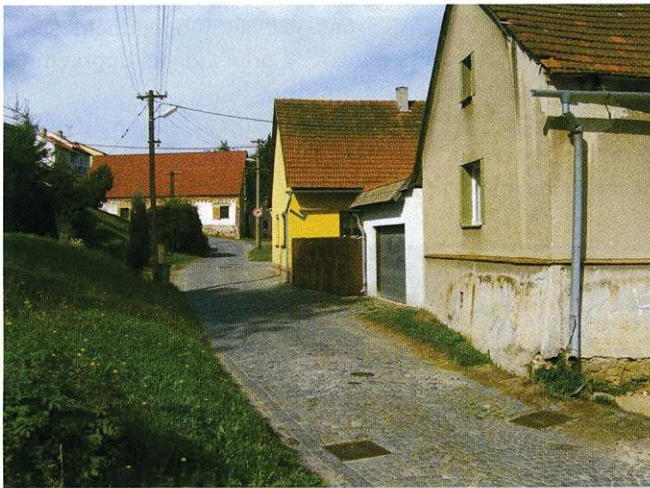
Obr. 4 Úzká vozovka bez rozšíření v obloucích, bez chodníků, parkovacích stání
