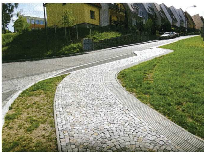
Obr. 13 Aplikace vodící línie umožní strojní úklid sněhu bez poškození obruby a odvodnění chodníku přirozeně do zeleně
