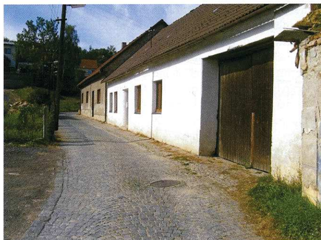
Obr. 2 Charakter původního stavu – vozovka na hranici životnosti, přidružený dopravní prostor neuspořádaný, zdrojem znečištění krytu a odvodňovacího systému
