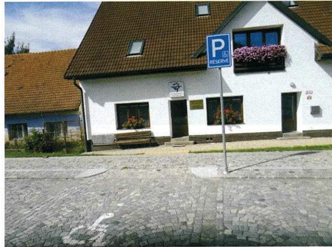
Obr. 10 Detail řešení snížené obruby u vyhrazeného stání
