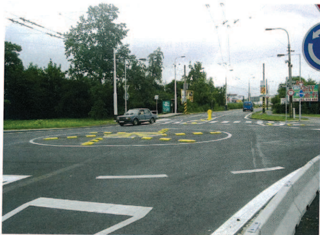
Celkový pohled na křižovatku po zprovoznění
