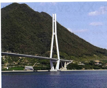
Obrázek 8: Tatara Bridge – největší závěsný most na světě
