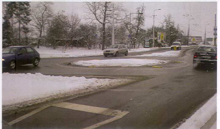
Obrázek 4: „Panenský“ středový ostrov i po týdnu od sněžení ukazuje dostatečné fungování MiniOK v principu kruhového objezdu.
