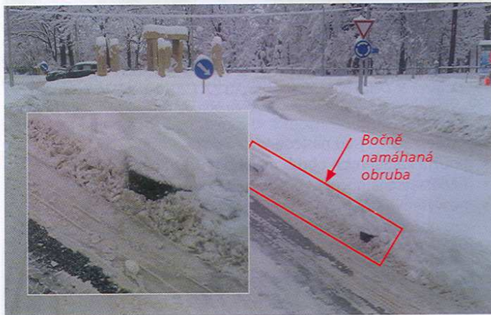
Obrázek 12: Zasněžený ostrůvek MPP s bočně namáhanou obrubou, detail opracované obruby, šikmý náběh usměrni kolofradlící, Pardubice – Ohrazenice.
