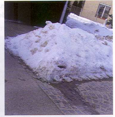
Obrázek 14: Vpusť vyřazená z provozu sněhovou bariérou, Pardubice – Svitkov, ulice Na Klínku
