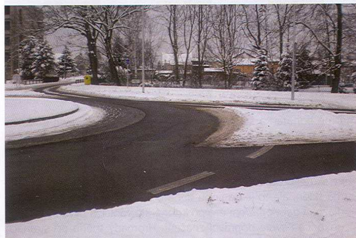
Obrázek 9: Pokud je prstenec výškově oddělen, je četnost přejíždění vnitřní obruby výrazně menší, Pardubice – Ohrázenice.
