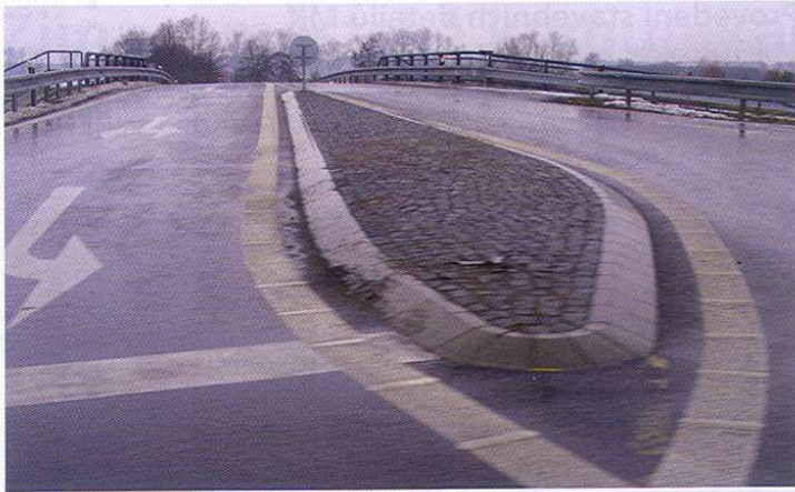
Obrázek 10: Ostrůvek byl v zimním období intenzivně pojižděn – byl naprosto nevýrazný, Opatovice nad Labem.
