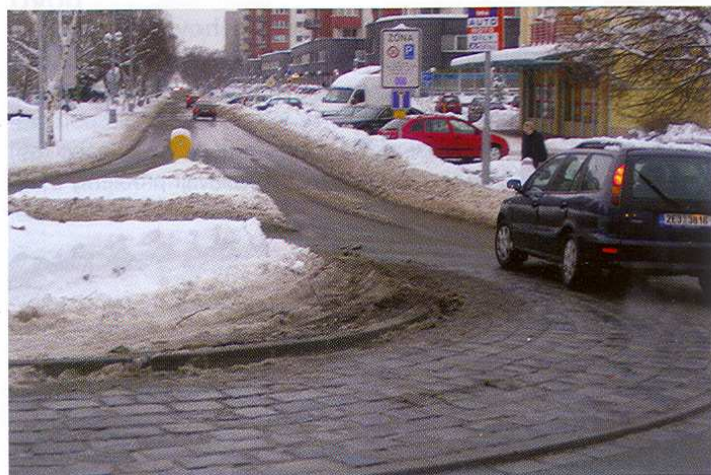
Foto 6: Na fotografii je zdokumentováno zkracování trajektorie průjezdu autobusu MHD při odbočování vlevo přes středový ostrov.
