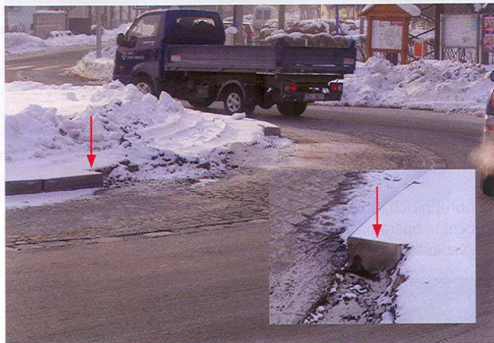
Obrázek 8: Detail poježděného ostrova 27.1.2010, detail rovného čela bez zámků a subtilního průřezu obruby, Pardubice – Staré Hradiště.
