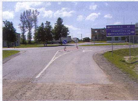
Obrázek 2: Litva: Široký dělicí ostrůvek. Ze snímku je patrné, že vedlejší komunikace zatím nemá živitný kryt.
