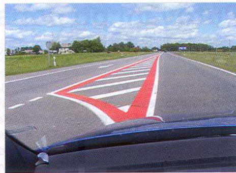
Obrázek 8: Lotyšsko: Červené zvýraznění vodorovného DZ – detail ukončení
