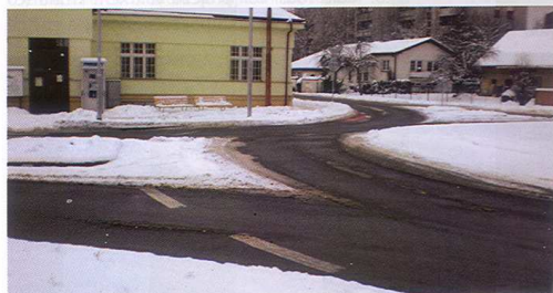
Obrázek 7: Pardubice Ohrazenice. Střední pojížděný prstec vytvořený zkoseným obrubníkem s převýšením 10 cm
