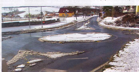
Obrázek 6: MiniOK \varnothing 21 m v Bystřici nad Pernštejnem; funguje jako OK
