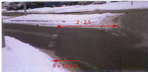
Obrázek 1: Pardubice, nábř. Závodu Míru, MOK \varnothing 25 m, pojížděný \varnothing 20 m
