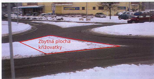
Obrázek 4: Pardubice, nábř. Závodu Míru, MOK \varnothing 25 m. Zházornění rozdílné trajektorie jízdy po okruhu a odbočení doprava
