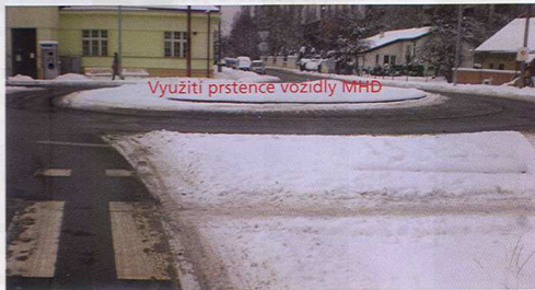
Obrázek 8: Využití středového prstence pojížděním vozidly MHD; pro osobní vozidla je převýšení 10 cm nepohodlné
